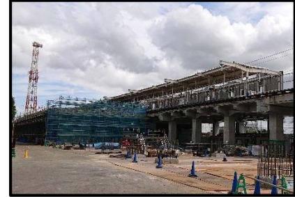
④高架橋二次施工（野田市駅 東側）
