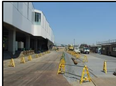
③仮線跡地（愛宕駅 東側）
