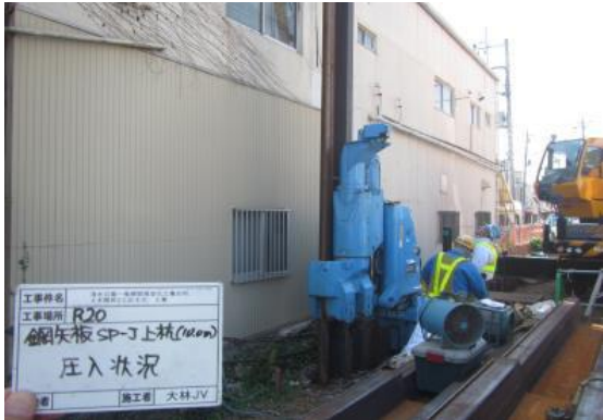
施工状況写真
