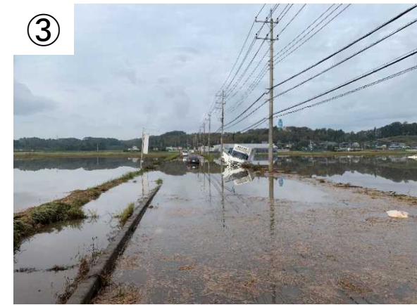
県道の浸水被害状況
