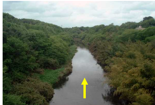
現況写真(弁天橋下流)
