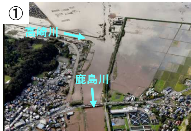
鹿島川の浸水被害状況(1)
