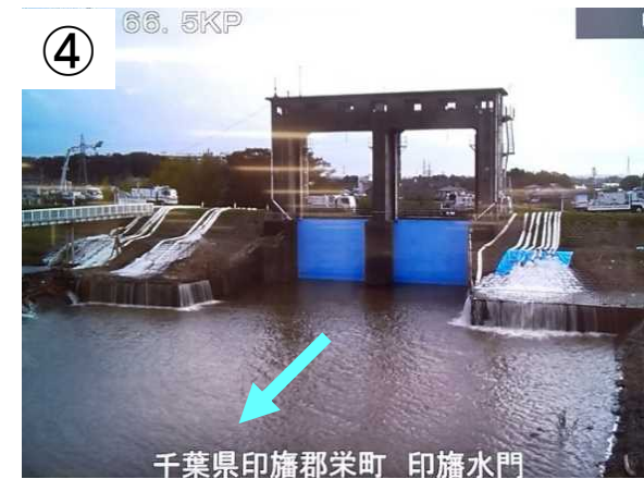
TEC-FORCE排水状況
