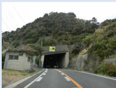
元名第二トンネル（当時の明鐘トンネル付近）
