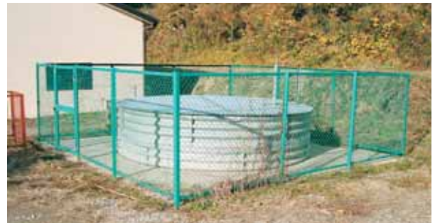
集水井工（南房総市大井）
