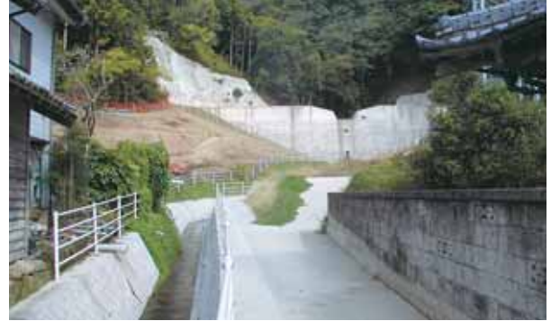
砂防堰堤工 仲根3（鴨川市西町）
