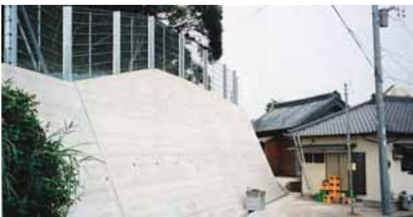
もたれ擁壁工（南房総市白浜町）
