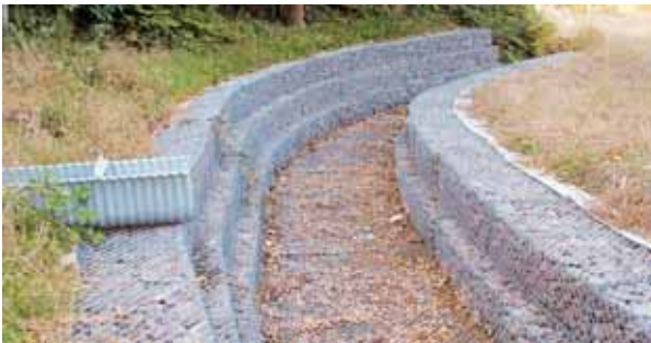
侵食防止工（南房総市大井）
