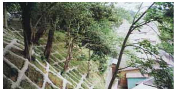
簡易法枠工（成田市田町）
