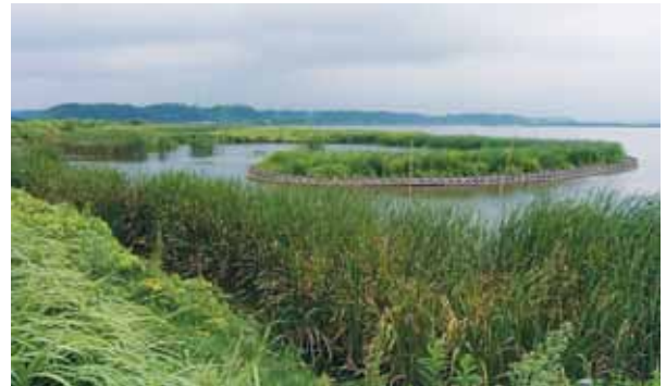
印旛沼・植生帯施工状況
