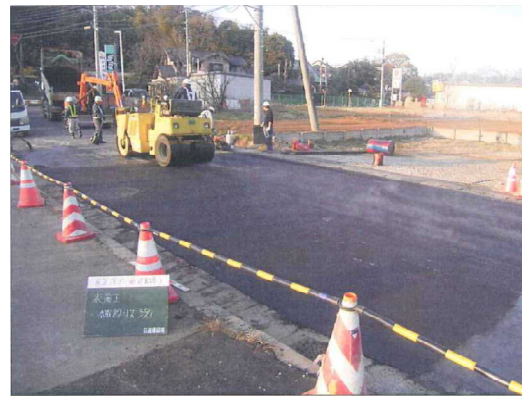
(一) 白井流山線 舗装工
