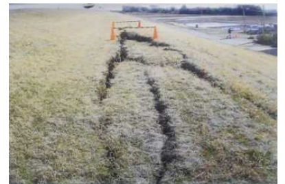
(国)356号 法面崩壊による路面亀裂
