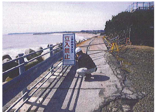
和泉浦海岸 バリケード設置
