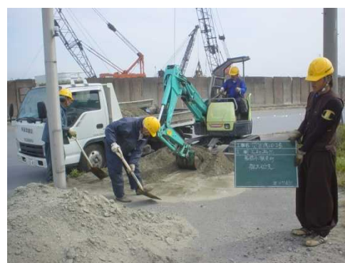
土砂撤去 (葛南港湾事務所)
