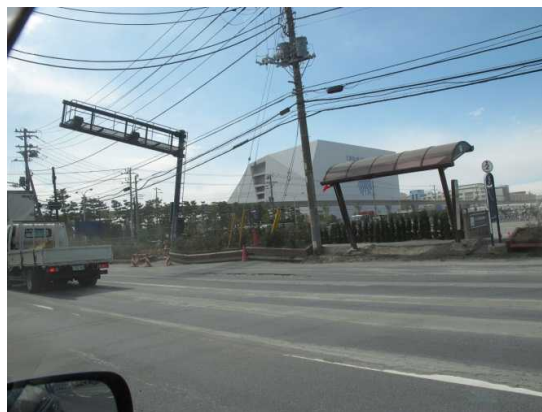
傾いたバス停と電柱等(浦安市)
