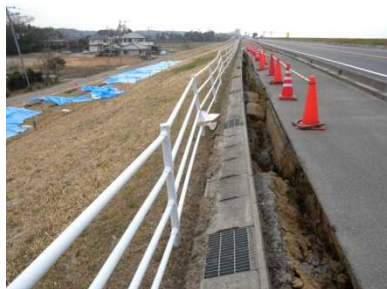
(国)356号 法面崩壊による路面亀裂
