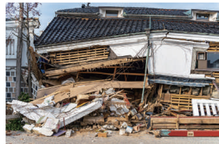
地震による被害例 (能登半島地震)
