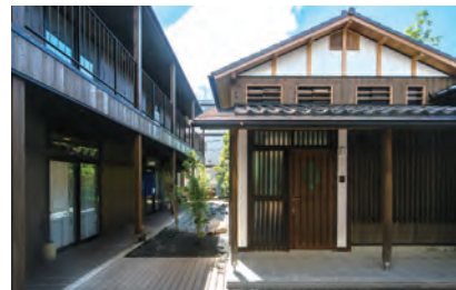
旧母屋復元 正面全景
