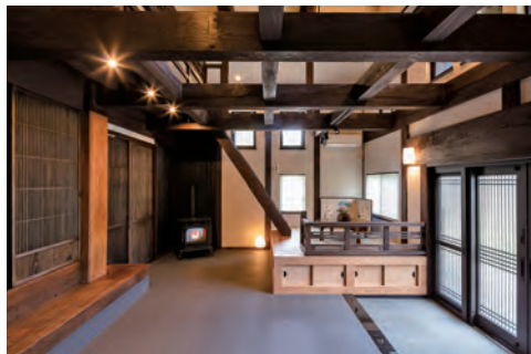
復元し吹き抜けとした玄関土間
