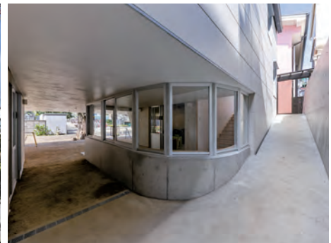
園庭と遊戯室をつなぐスロープ
