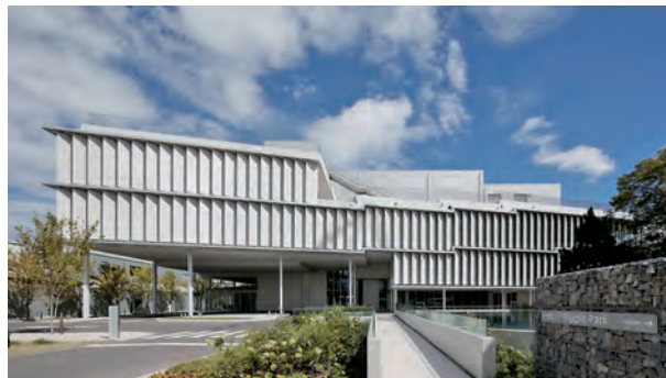
西陽に対してアルミエキスパンドメタルによるルーバーを設置。隣接するゲストを迎える緑地と一体的に整備。
