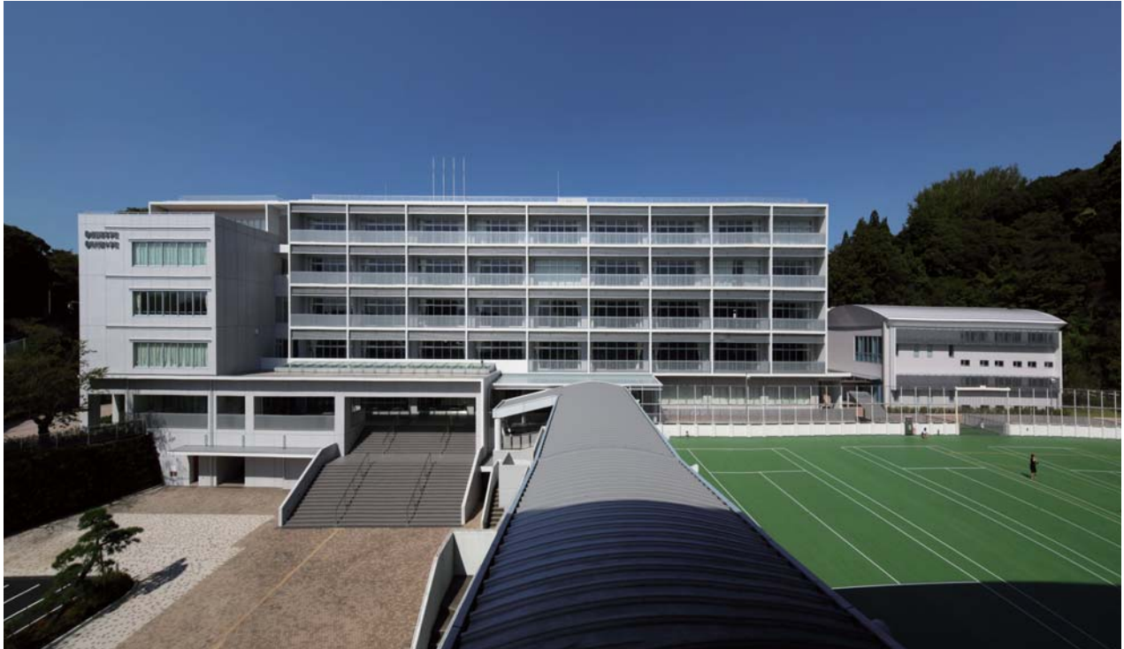
緑豊かな成田山を背景に佇み、スカイラインと呼応する外観 (撮影/エスエス東京 横瀬 博一)
