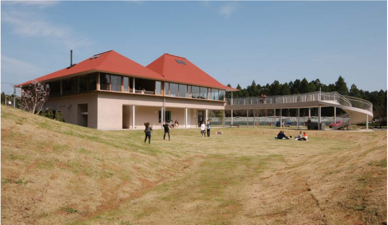
庭からの外観 レストラン、オフィス、広場などの機能が割り当てられた4つの寄せ棟を複合した屋根 (撮影/アトリエ・ワン)
