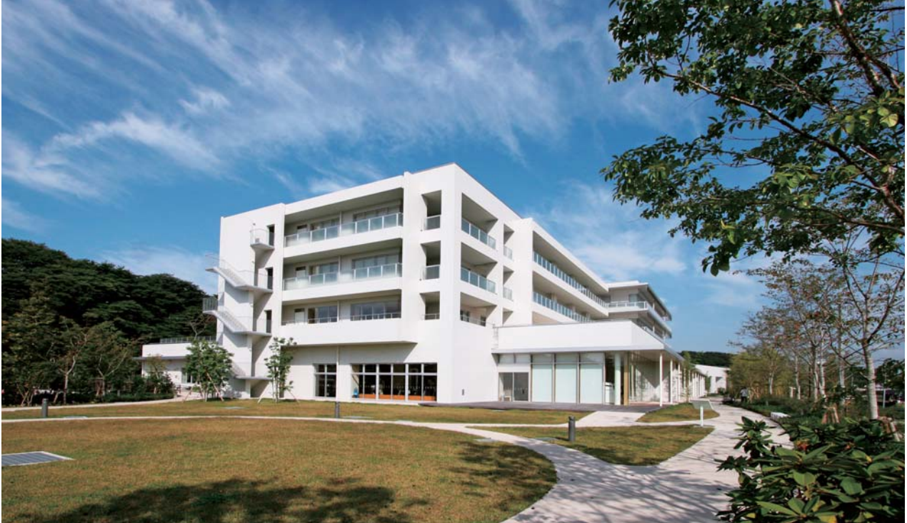
東側外観 遊歩道より望む
