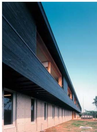
前庭からの外観
