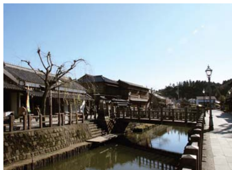
樋橋と伊能忠敬旧宅
