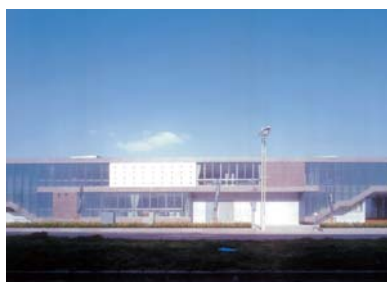
千葉市立美浜打瀬小学校 (景観)
