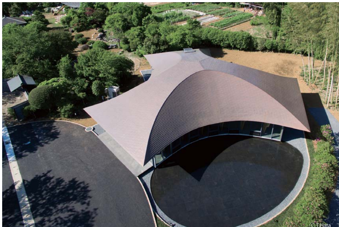
南西上空からの俯瞰
