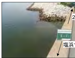
H21年6月12日 (施工前)
