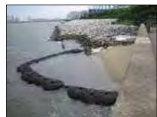
H21年7月10日 (施工後約2週間) 撮影時潮位A.P.+0.9m程度
