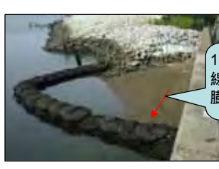
H21年9月4日 (施工後2ヵ月半) 撮影時潮位A.P.+0.5m程度
