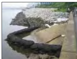
H21年7月22日 (施工後約1ヵ月) 撮影時潮位A.P.+0.04m程度
