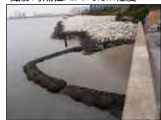
H22年2月16日 (施工後約7ヵ月) 撮影時潮位A.P.+0.9m程度
