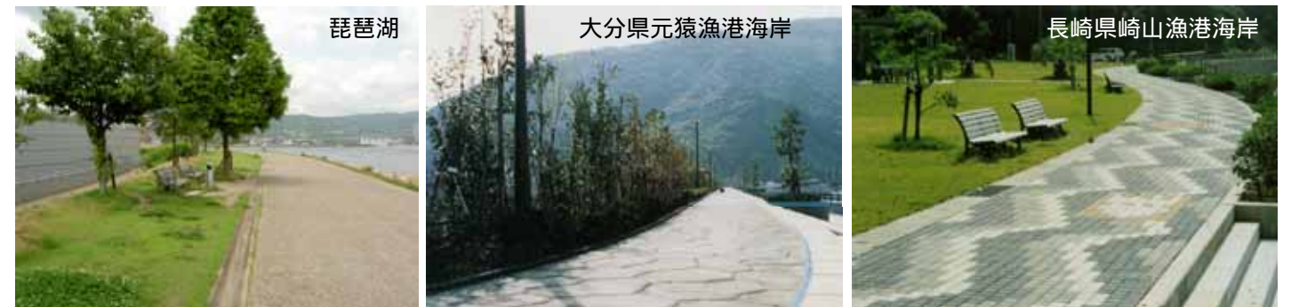
天端の施設(植栽、遊歩道、ベンチ)
