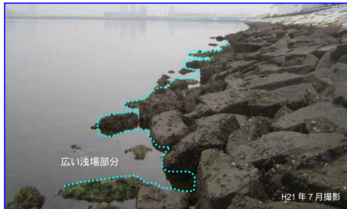
現在の完成断面区間の法先は、自然の凹凸が生じている。
