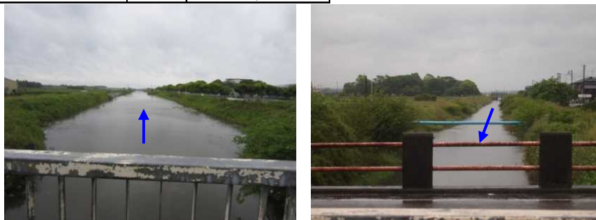
治水基準点の中橋より改修済みの下流と未改修の上流を望む。河道拡幅に合わせて、中橋も架け替えを予定している。(平成27年5月19日撮影)
