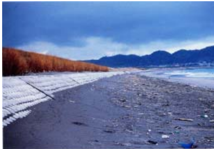
写真 防潮工 (館山市・平砂浦)
