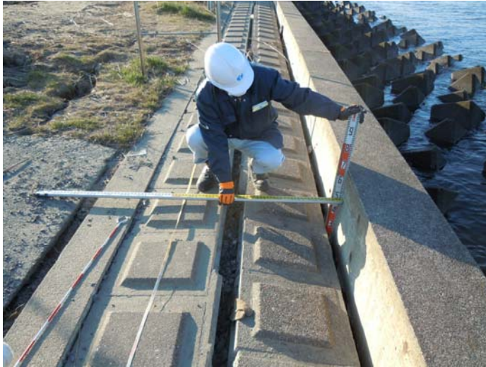
低水護岸沈下
