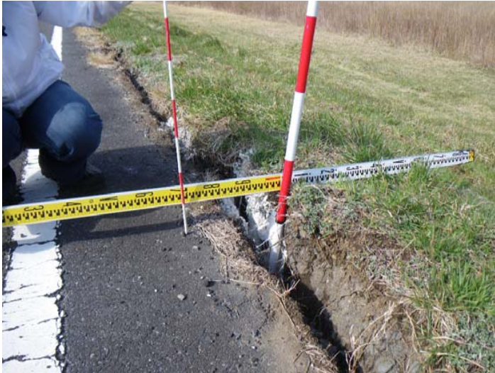
堤防天端亀裂
