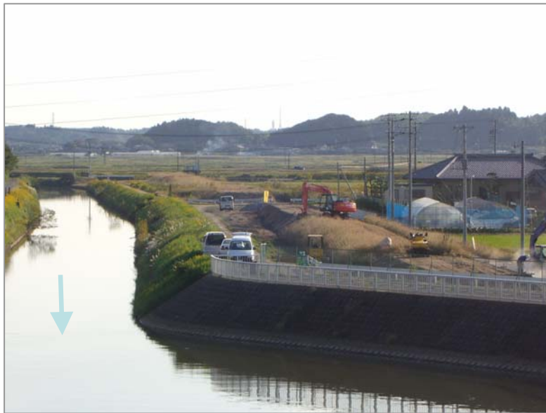
下流左岸(十日川排水機場付近)拡幅工事の様子
