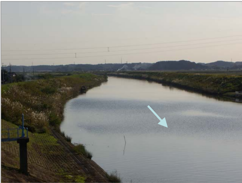
新川水門より上流を望む
