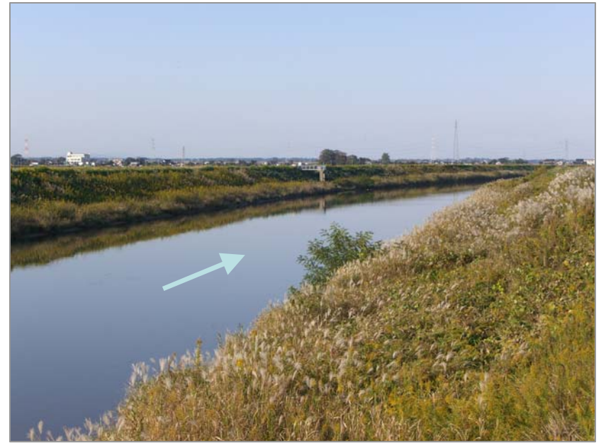
派川根木名川分派点から下流を望む
