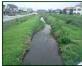
川間橋より下流側の現在の状況
