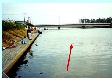
九十九里橋上流
