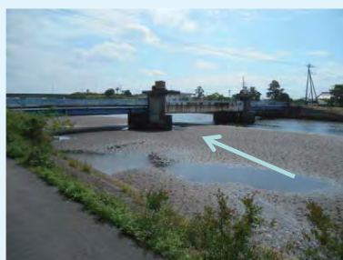
龍宮堰(橋)を 上流左岸側からみる
