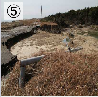
⑤ 津波によりアスファルトがえぐられ、電柱も折れ曲がっている海岸（蓮沼地区）
