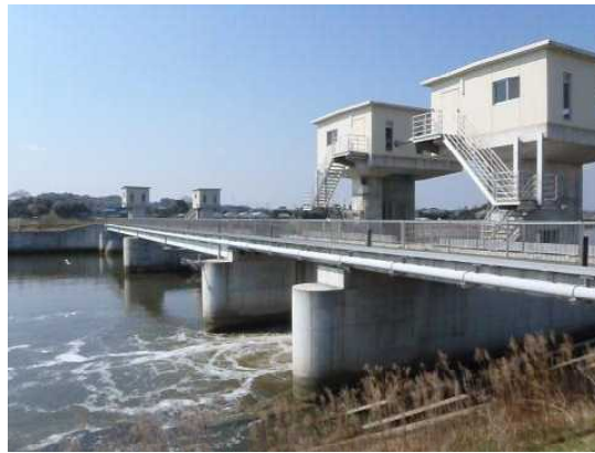
■ 現在の松潟堰の様子
