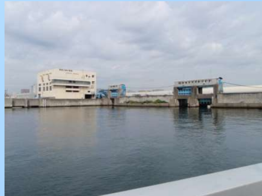
海老川排水機場
