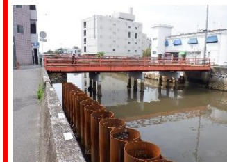
護岸整備（矢那川）
