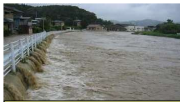
【平成17年】平久里川横峯大橋付近浸水状況
