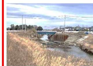
橋梁改築（中橋）
