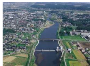
河道拡幅（栗山川中流域）
