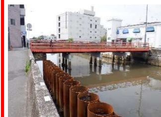
護岸整備（矢那川）
