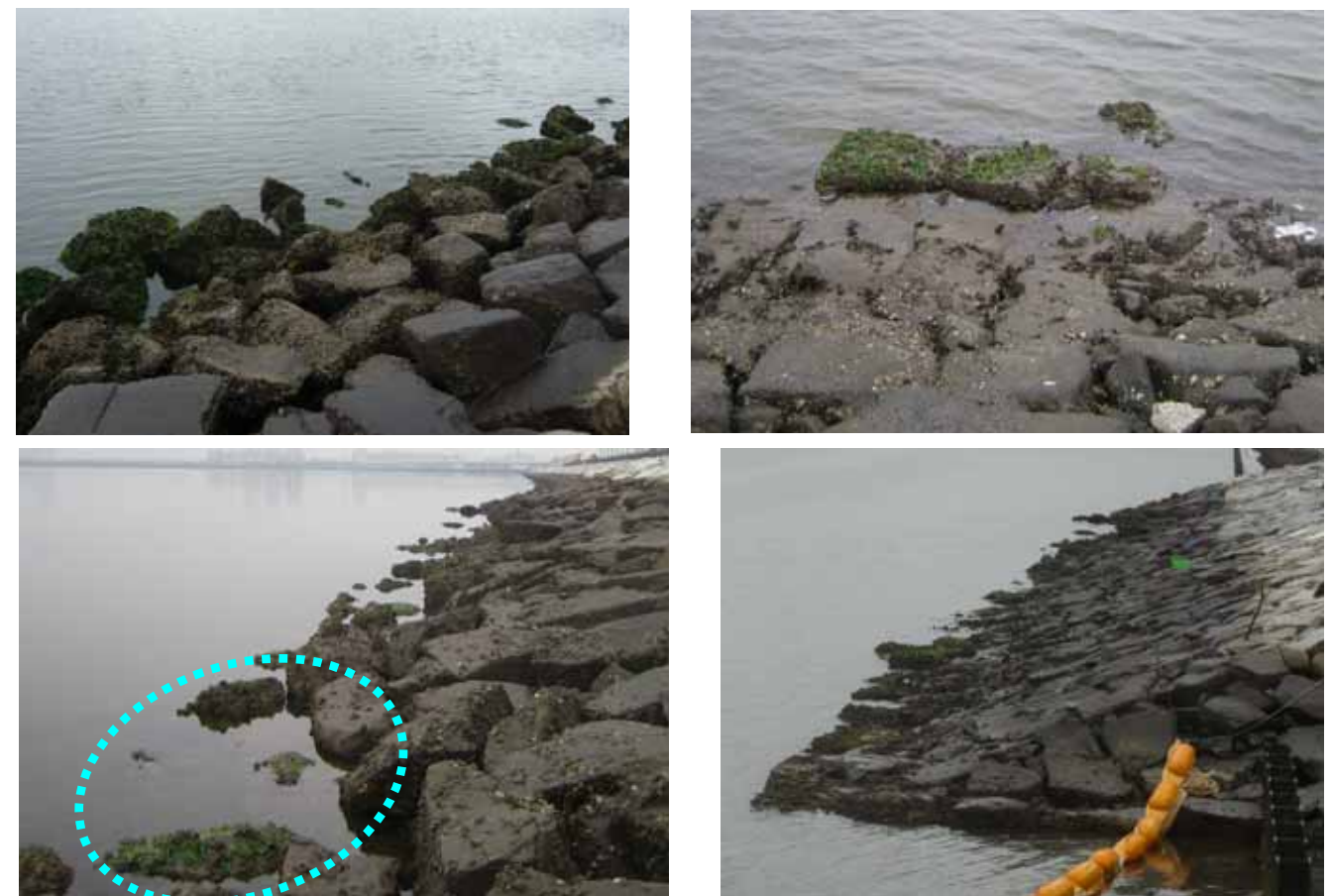
現状では、人工的に石積の勾配を変化させなくても、法先に自然の凹凸が生じている
