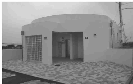
図表 2-2-3 改修した公衆便所
