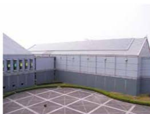
現代産業科学館 太陽光発電装置
