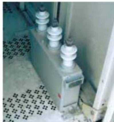
PCBを含んだ絶縁油を使用した電気機器（トランス（左）、コンデンサ（右））の例
