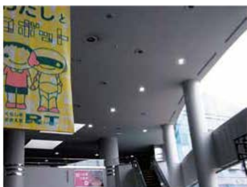
現代産業科学館 LED照明
