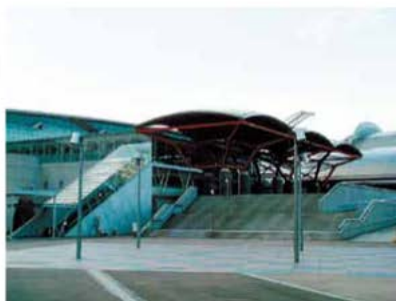
幕張メッセ正面広場LED照明
