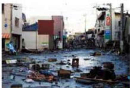
津波による被災状況
