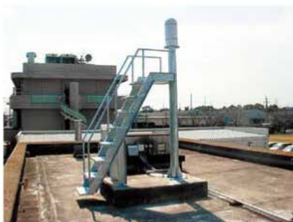
<環境研究センターに設置されている モニタリングポスト>
