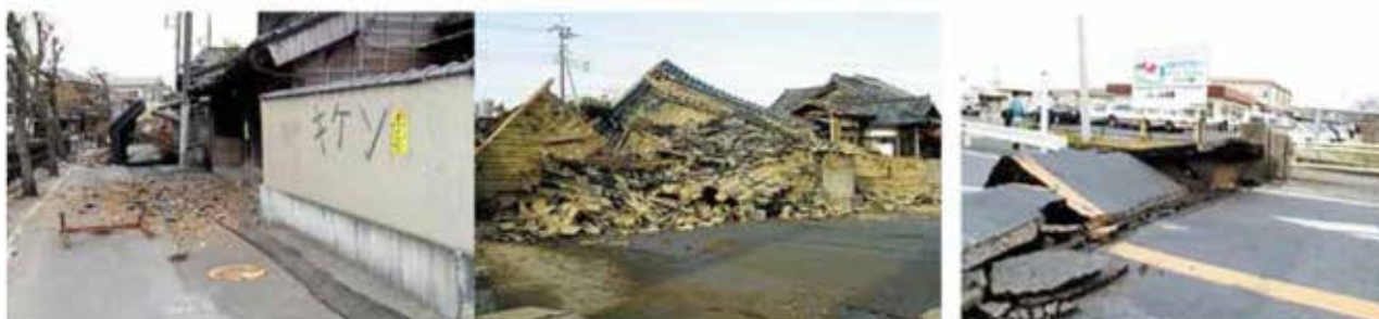
地震・液状化による被害状況
