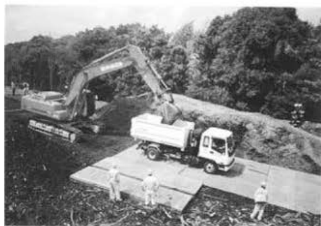
（不法堆積された木材チップの除去）
