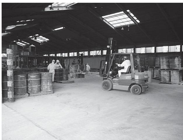
○ 屋外に不適正保管されていた廃コンデンサ等にPCB（ポリ塩化ビフェニル）を含む油が使用されていたことが発覚し、錆等の腐食の進行によりPCBの漏出拡大が危惧されたことから、漏出防止対策としての支障除去事業を実施しま
