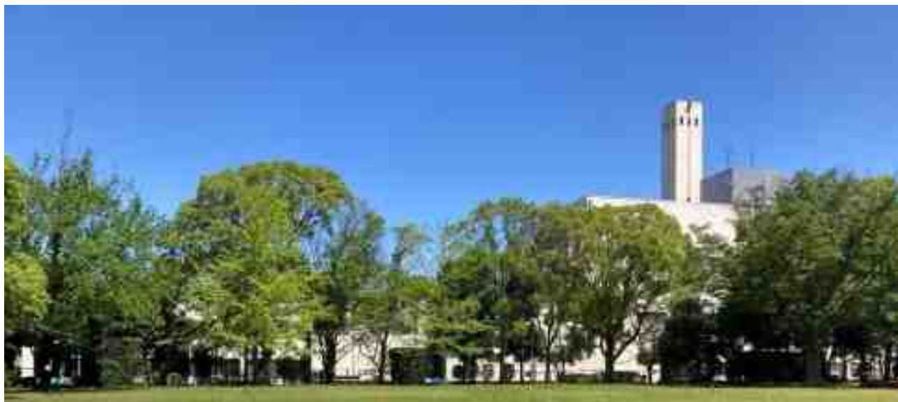
第2松戸市清掃工場(クリーンセンター)
