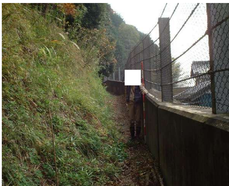
写真4. 6. 2 待受対策施設ポケット状況
