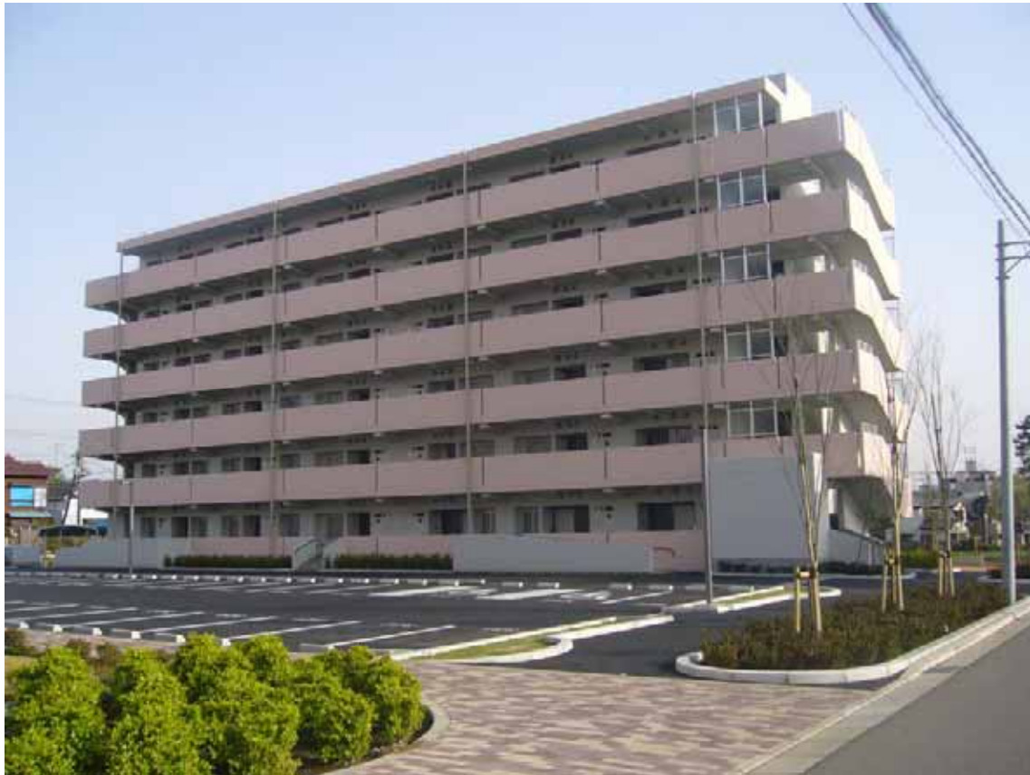
実籾県営住宅（習志野市）第4期（建替事業）
