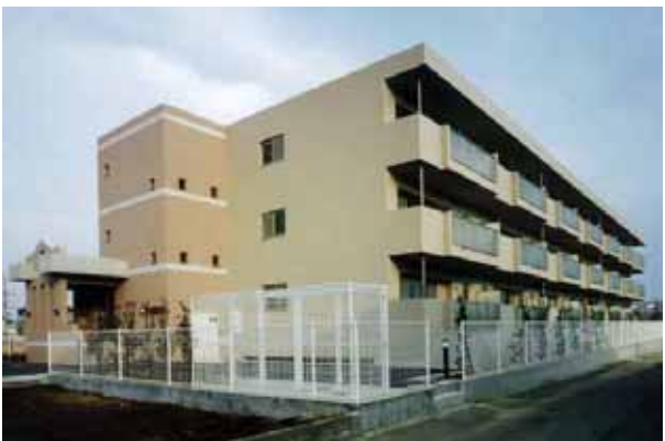
ロアジール上山（船橋市）
