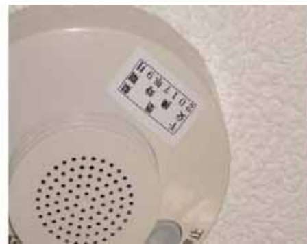
火災報知機設置
