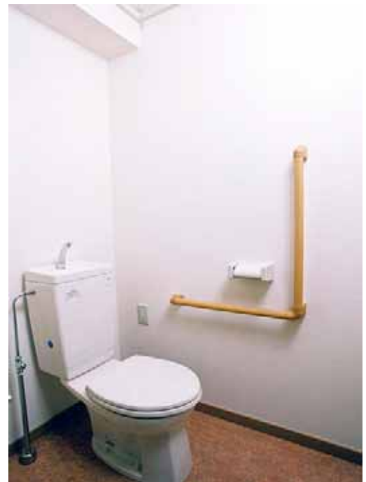
手すりのついたトイレ
