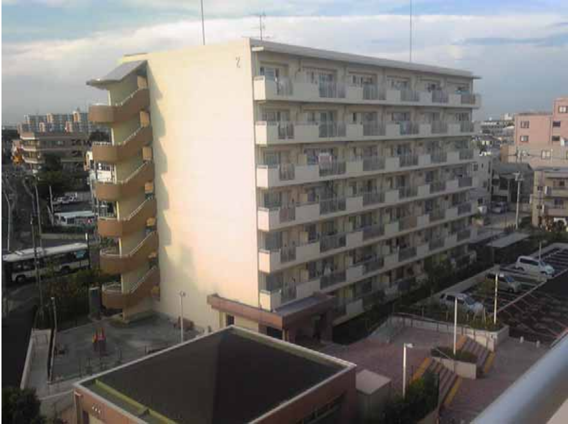
松波県営住宅（千葉市）第2期（建替事業）
