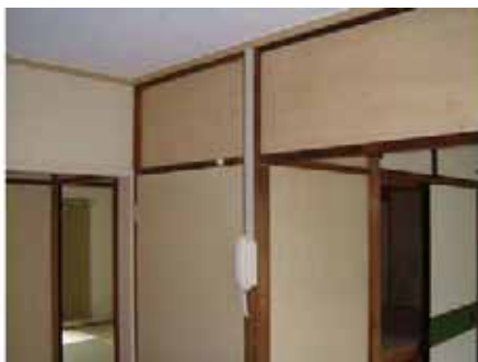
インターホン設置（室内部）
