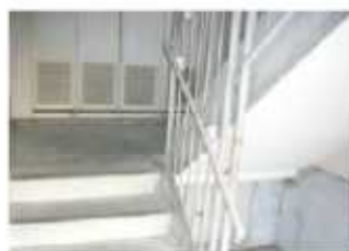
階段手摺の改修後
