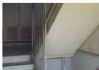
階段手摺の改修前
