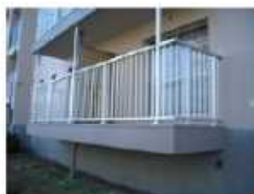
バルコニー手摺の改修後
