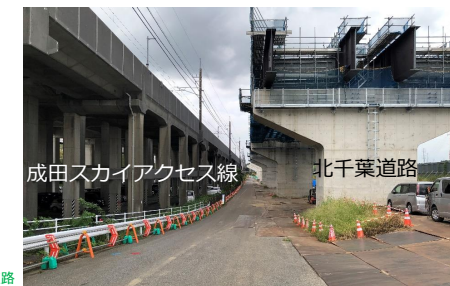
国道464号 北千葉道路（成田市）
