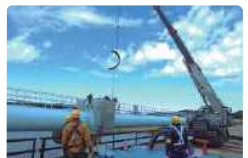
船戸水管橋(印西市)
