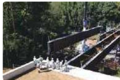
国道296号(八千代市)
