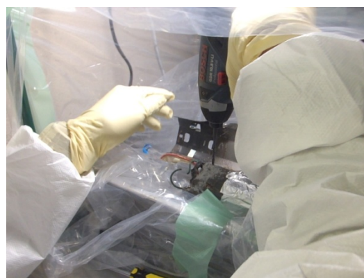
コンデンサ外付け型廃安定器充填材の採取
