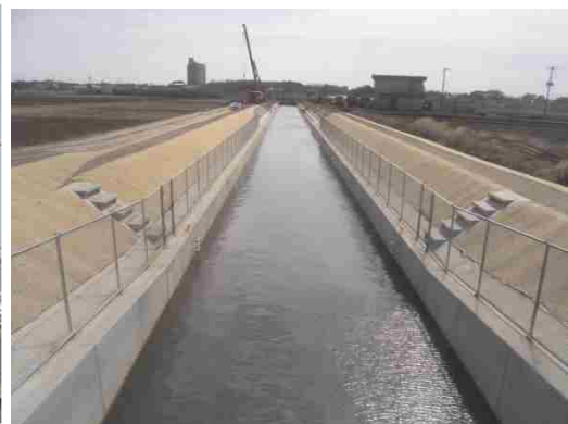
排水路の拡幅・かさ上げ
