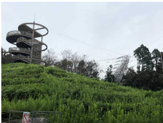
君津市かずさ小糸（鉄塔倒壊）
