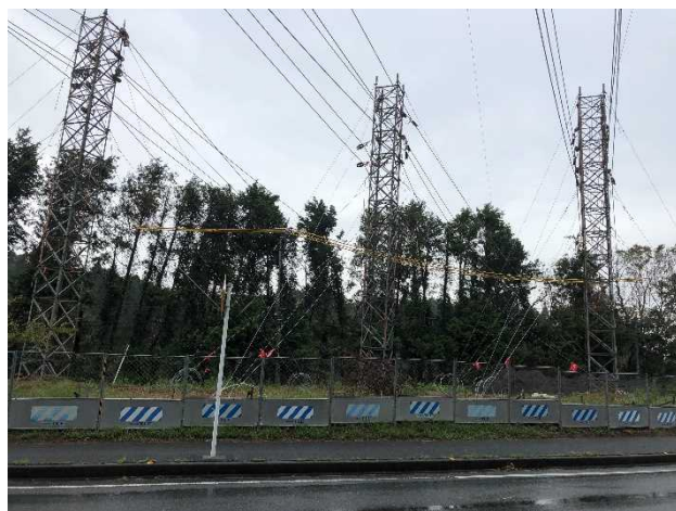
君津市かずさ小糸（鉄塔倒壊）
