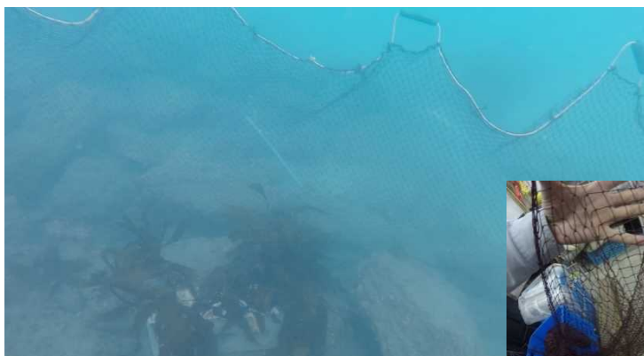
ウニフェンスの設置
