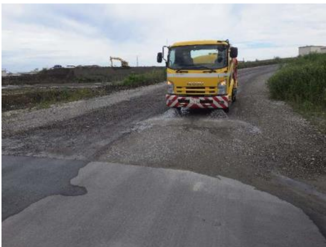
散水車による散水
