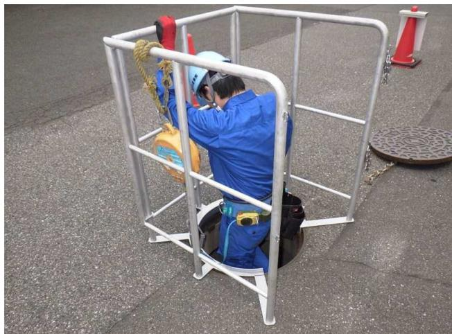
「酸素濃度計、作業表示、送風機設置」
