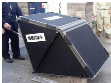
(5) 組み立てた防音パネルの固定
