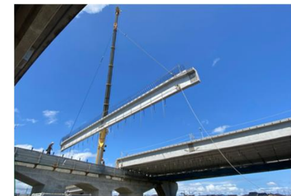
P C橋架設工
