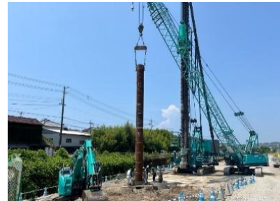
鋼管ソイルセメント杭工
