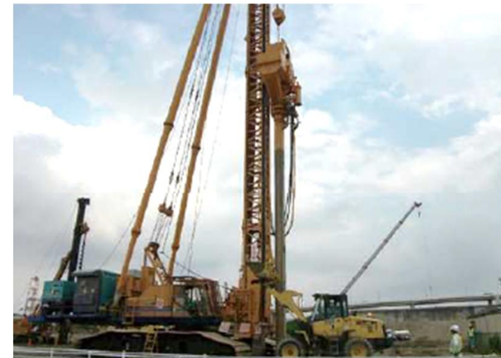
軟弱地盤処理工
