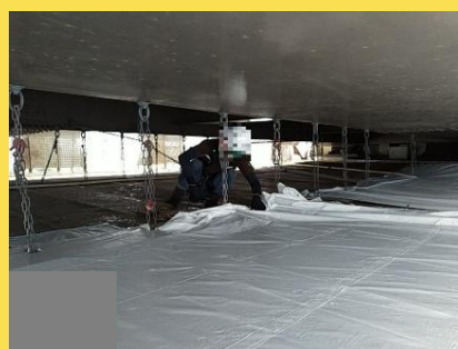
橋梁補修工 （塗装塗替足場工）
