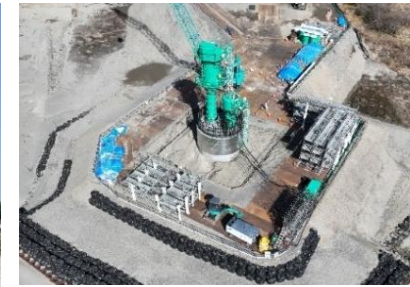
ニューマチックケーソン工
