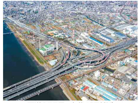
国道357号 高谷JCT付近
